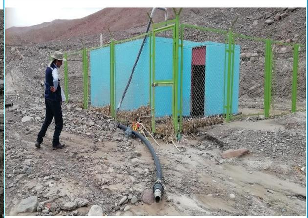
Tramo de Línea de Conducción afectada y Línea de Aducción expuesta por ingreso de Huayco
