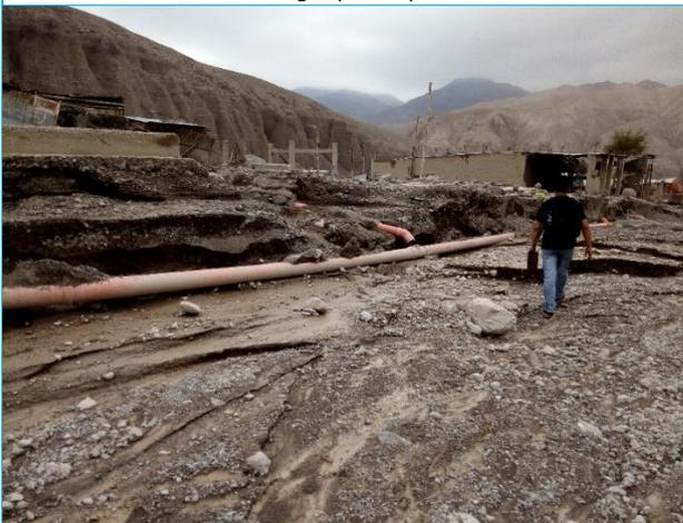
Vista del colector de desagüe expuesta, el huayco erosiono la calle.
