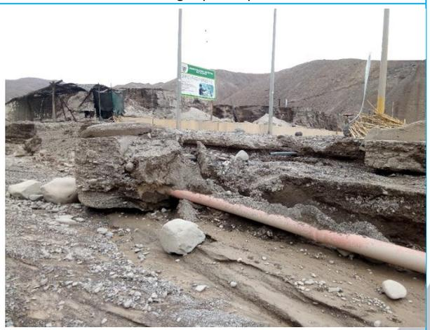
Vista del Buzón de desagüe expuesta, Tubería PVC-UF 200mm., expuesta.
